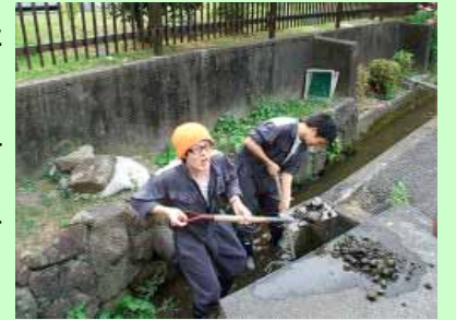
(学生寮前の側溝を清掃中の寮生)
